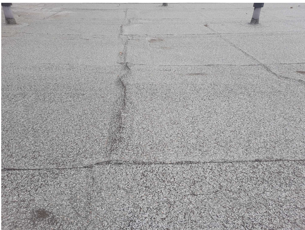
Obr. 2 – detail nerovností v asfaltovém pásu
