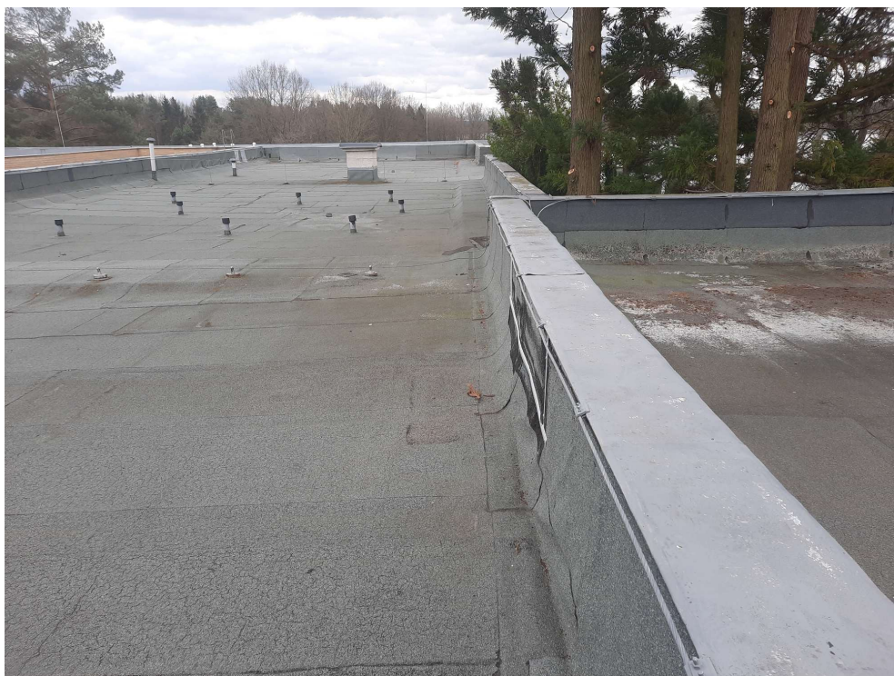
Obr. 5 – pohled na konstrukci atiky se současným uchycením hromosvodu
