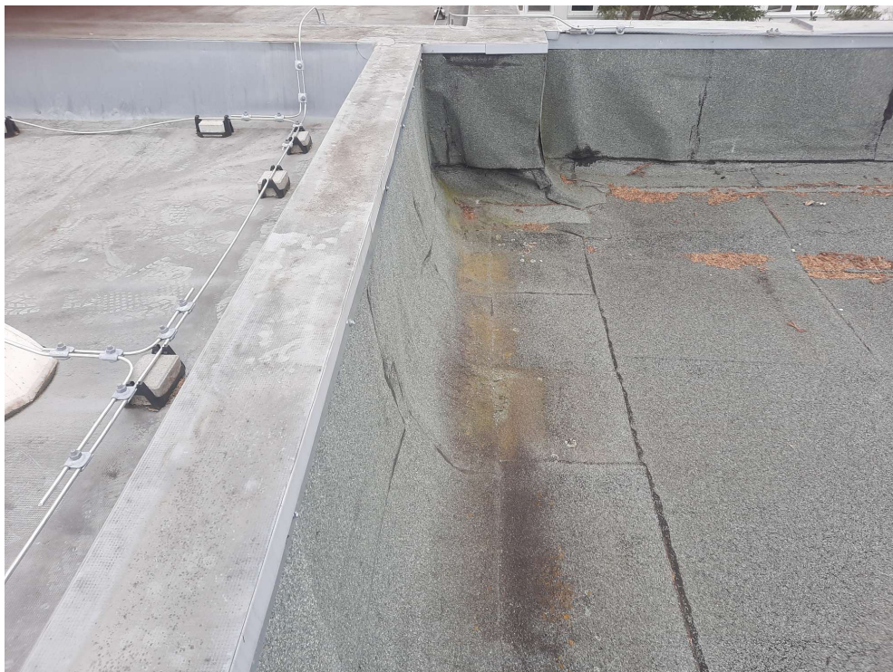
Obr. 3 – pohled na konstrukci atiky s PVC-P fólií navazující střechy
